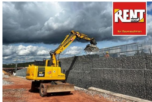
Schlüter-RENT Mobilbagger PW160 im Einsatz
