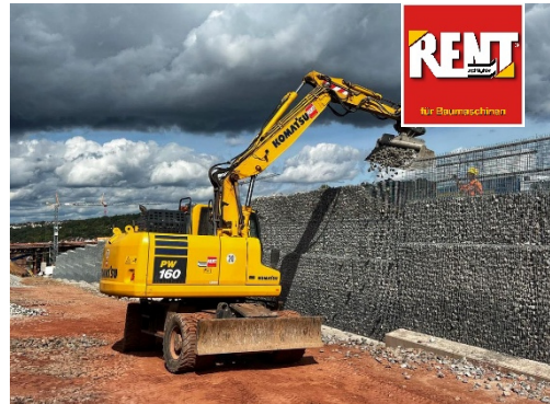
Schlüter-RENT Mobilbagger PW160 im Einsatz
